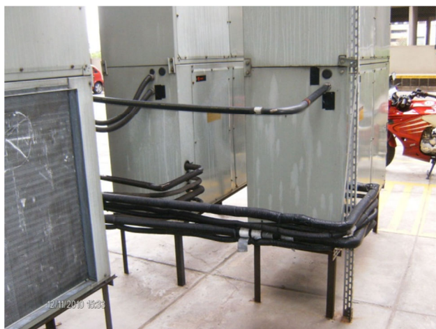
Figura 55 – Condensadores – vista dos requadros de cantoneiras Fonte: Autor
