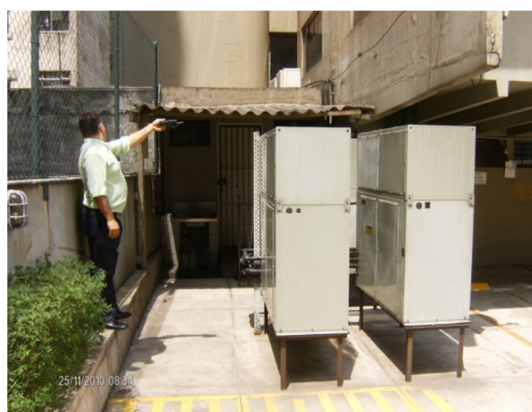
Figura 29 - Medição nº 3, entre o muro de divisa e o condensador 3 Fonte: Autor
